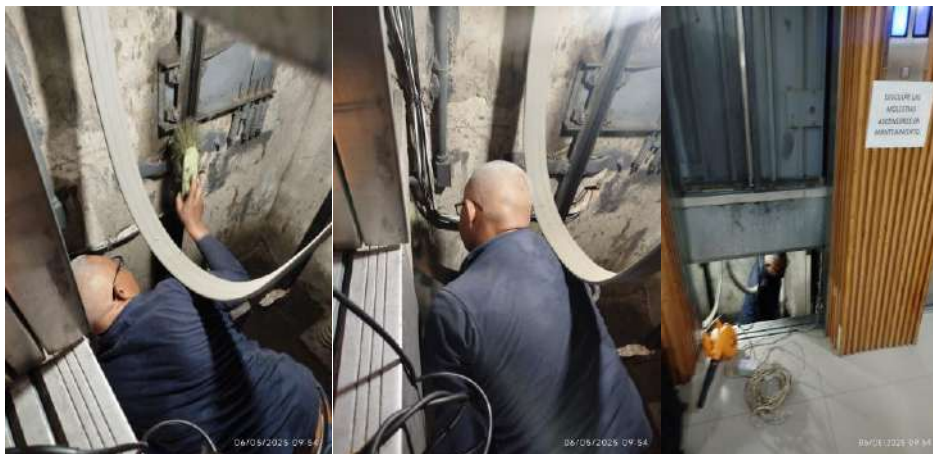
Limpiezas en pozos
