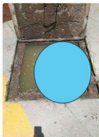
Poso de aguas negras tapado
