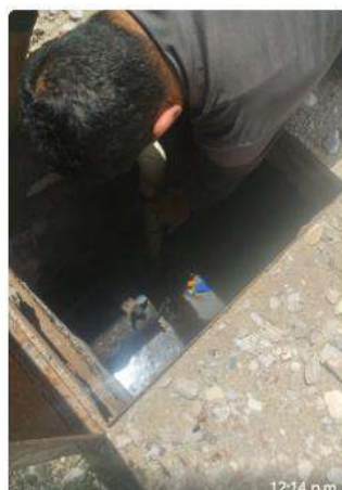
Realizando arreglos del flotador de la bomba de aguas negras
